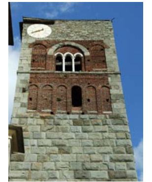
La torre campanaria con il quadrante dell'orologio.
