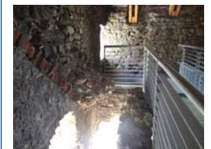
Attraverso i nuovi piani grigliati si possono ripercorrere gli ambienti interni della torre.
