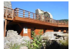
I locali di servizio situati sotto la tribuna.
