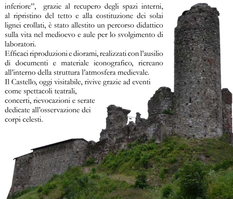
Veduta della torre e del castello dal lato Nord - Ovest.
