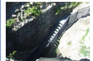
Gli ambienti superiori sono stati messi in comunicazione con l'ingresso e gli ambienti sotterranei grazie ad una scala in metallo.
