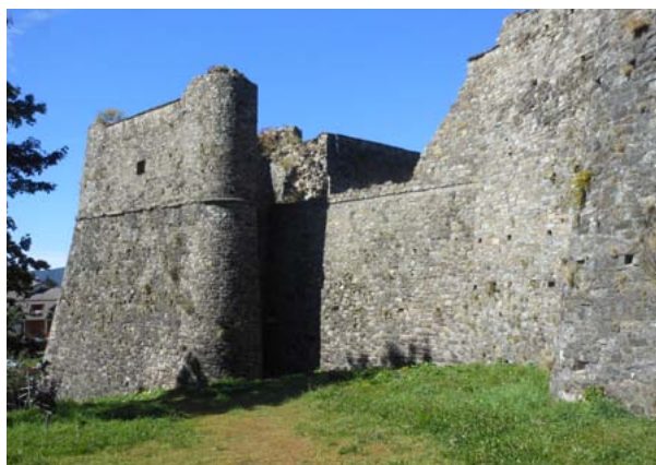
Le grandi mura perimetrali rinforzate da baluardi angolari cuneiformi.
