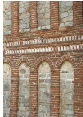
Il paramento esterno composto da tessuto murario in pietra e laterizio con duplice funzione portante e decorativa.
