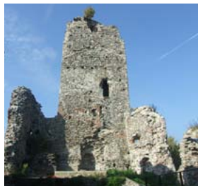
La torre semicircolare vista dalla corte superiore.
