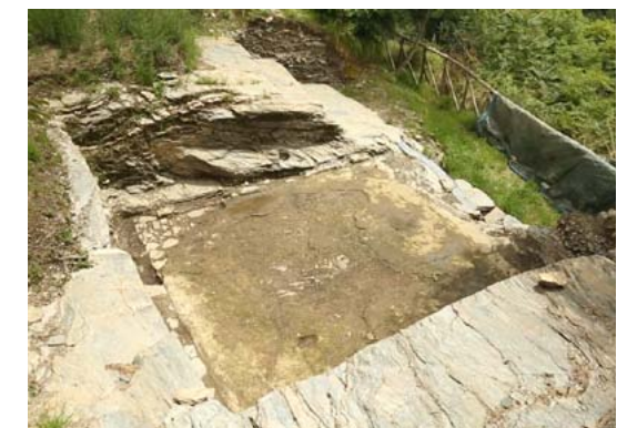
La roccia tagliata artificialmente porta ancora impressi i segni del piccone.
