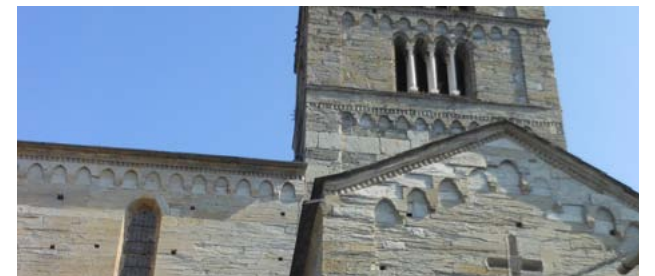
L'apparato decorativo nei paramenti murari esterni configurato nelle lesene d'angolo e negli archetti pensili a sesto acuto.
