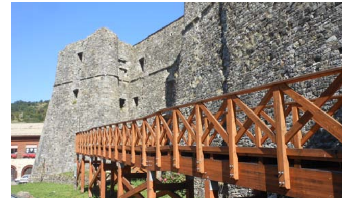
Passerella lignea per l'accesso al Castello.
