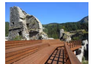
Sullo sfondo della tribuna il piccolo baluardo disposto ad ovest.
