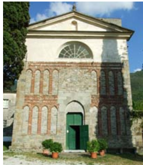
La fronte principale della chiesa abbaziale.
