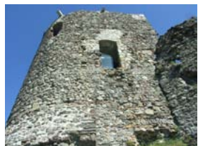
Con l'intervento di restauro si è conseguito il consolidamento del paramento murario nella torre, anche attraverso l'integrazione del tessuto lapideo mancante.
