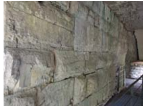
Muratura in grandi conci rifilati a scalpello alcuni dei quali in bugnato a cuscino.
